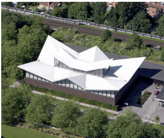
Sala Sporturilor (Danemarca): RENOLIT ALKORTOP
